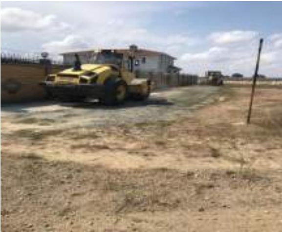
Kemalpaşa Mah. Şair Sokak Stabilize 330 m 2
