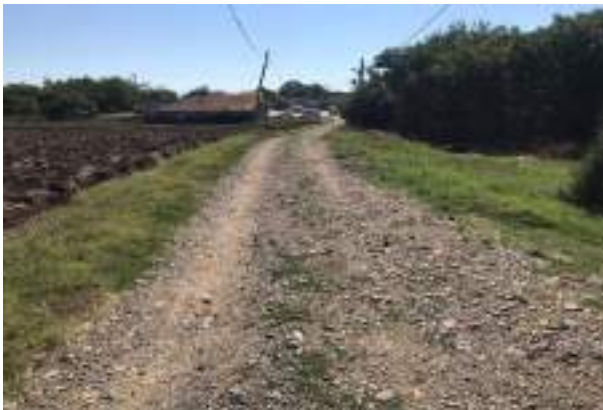
Sofular Mahallesi Köyiçi Parke Taşı 1700 m 2
