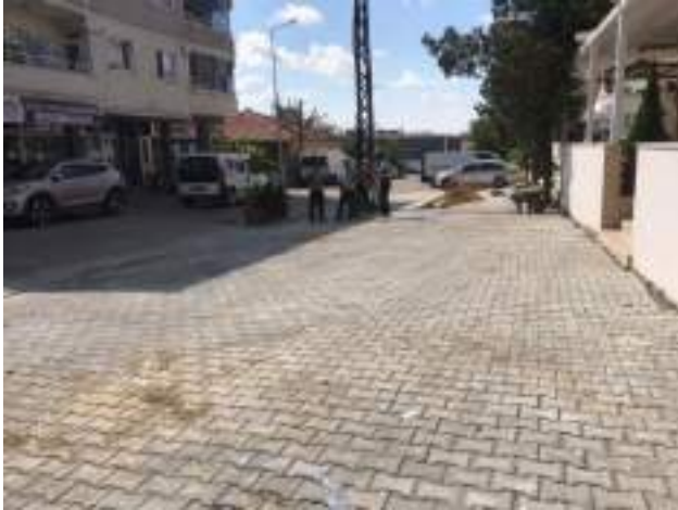
Pazarcık Mahallesi Sabit Sokak Kaldırım 255 m 2
