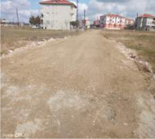
Yeni Mahalle Öğüt Sokak Stabilize 435 m 2
