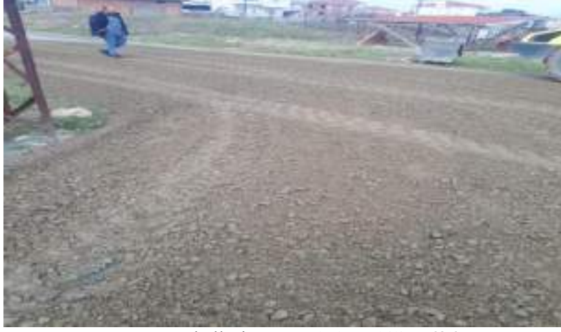
Ayaspaşa Mahallesi Mert Sokak Stabilize 686 m 2
