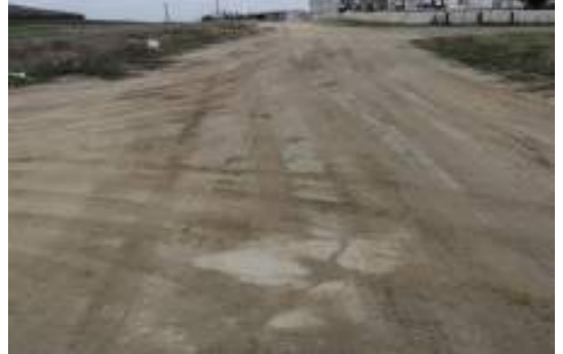
Merkez Mah. Peker Sokak Stabilize 600 m 2
