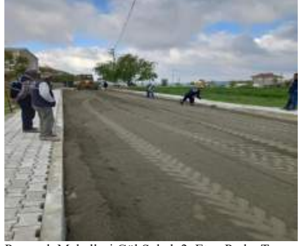
Pazarlık Mahallesi Gül Sokak 2. Etap Parke Taşı 603 m 2
