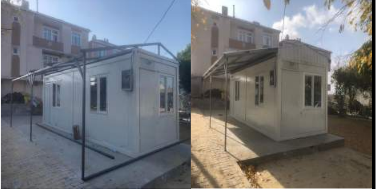
Safaalan Mahallesi Sağlık Ocağı Hizmet Binası Çatı Yapımı
