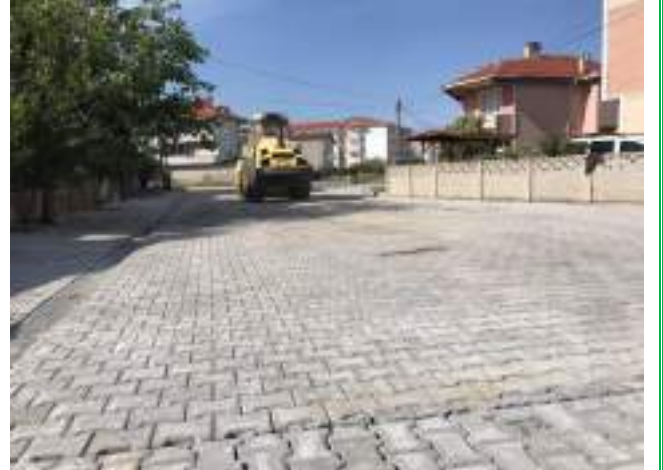
Yeni Mahalle Kayrak Sokak Parke Taşı 1250 m 2
