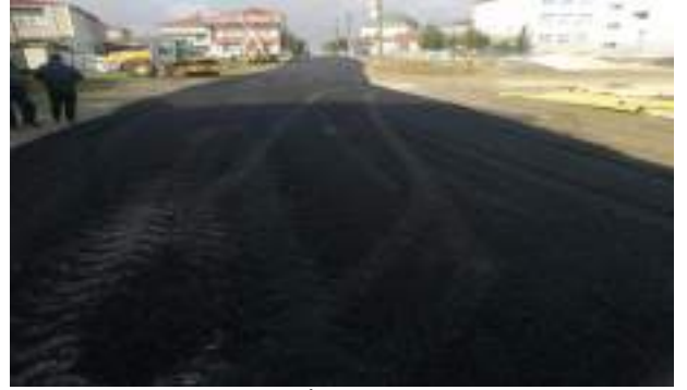
Cumhuriyet Mahallesi İstiklal Caddesi Asfalt Kırığı- Sıcak Asfalt 3550 m 2
