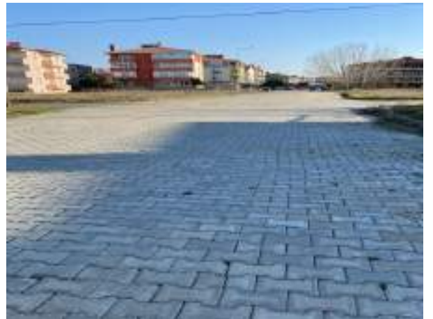
Kemalpaşa Mah. Kültür Sok. Stabilize 930 m 2
