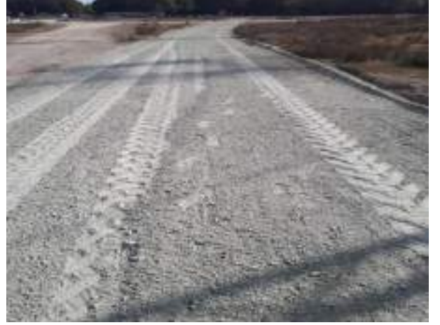
Sefaalan Mahallesi Köyiçi Stabilize 1800 m 2
