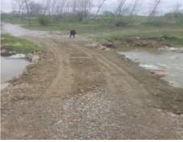
Yeni Mahalle Soğuksu Köprüsü Stabilize 100 m 2
