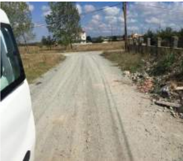
Yeni Mahalle İpek Sokak Asfalt Kırığı 3537 m 2
