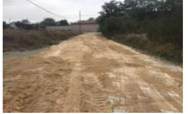
Sofular Mahallesi Çıkmaz Sokak Stabilize 430 m 2
