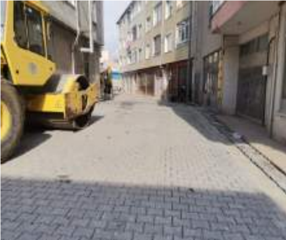
Ayaspaşa Mahallesi Pelit Sokak Parke Taşı 407 m 2
