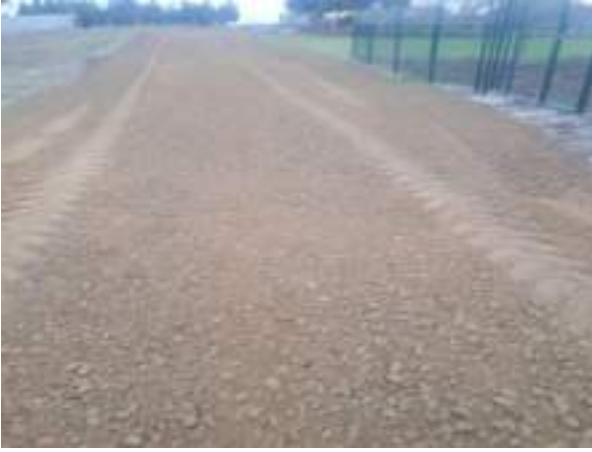
Çayla Mahallesi Parseller Stabilize 1000 m 2
