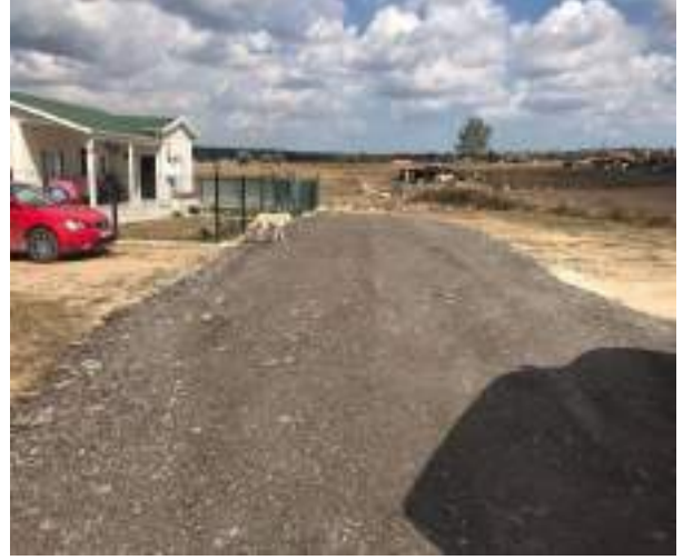
Yeni Mahalle Demet-Damla-Kamelya Sokak Asfalt Kırığı 4340 m 2
